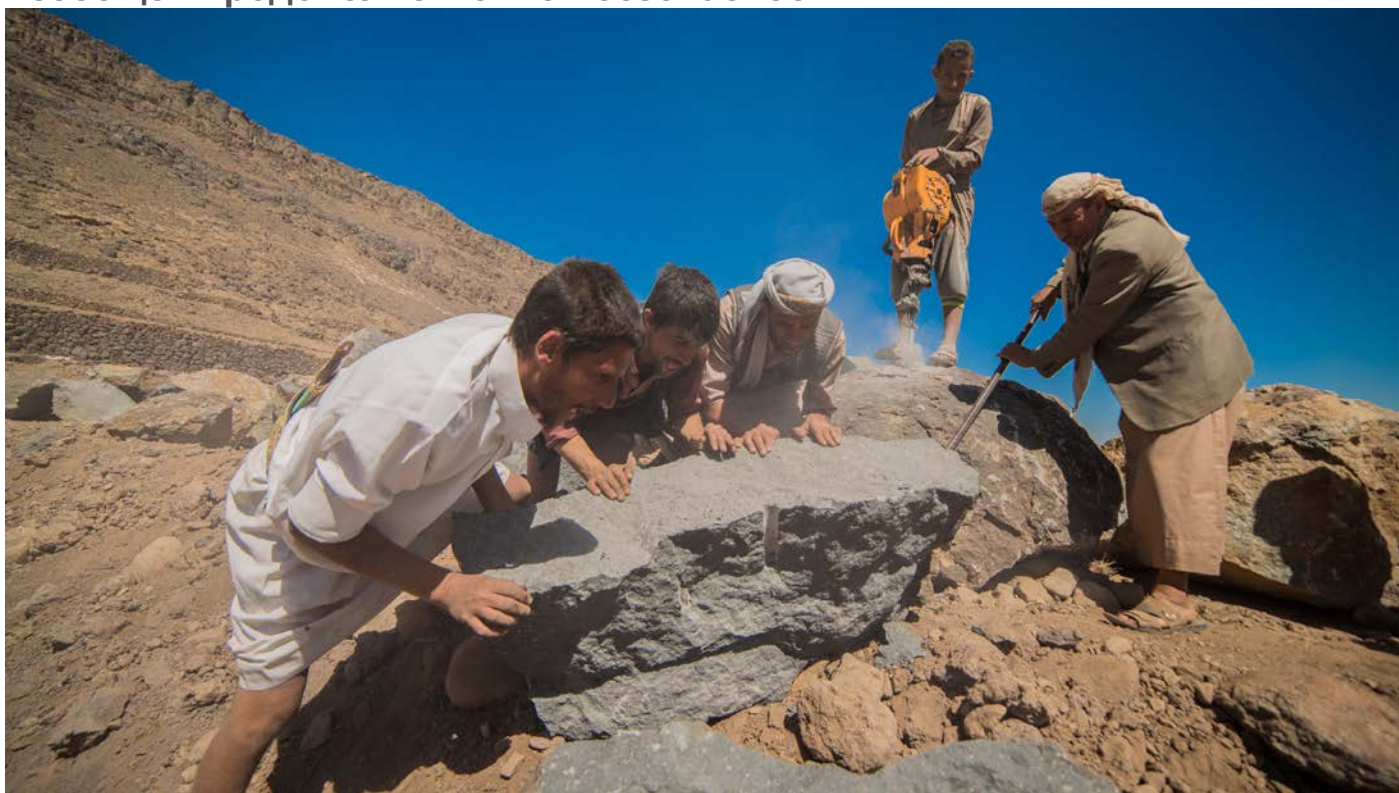
Строительство водохранилища в Йемене.
